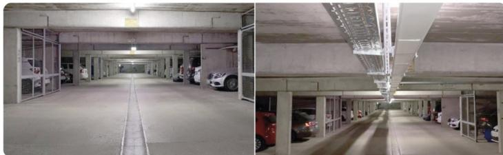
Referenzprojekt in Zorneding: Tiefgarage vor und nach Einbau der Ladeinfrastruktur, mit zentraler Deckenschiene
