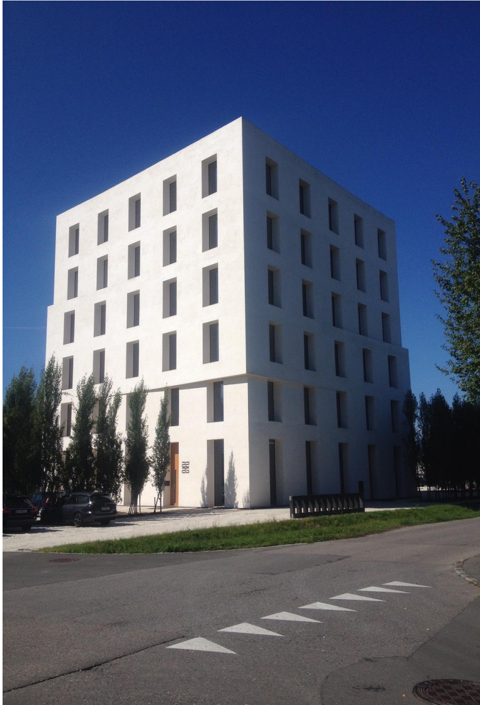
Bild 1 :Haus ohne separate Heizung in der Schweiz, Baumschlager Eberle Architekten Lustenau Foto Ingenieurbüro Hausladen
